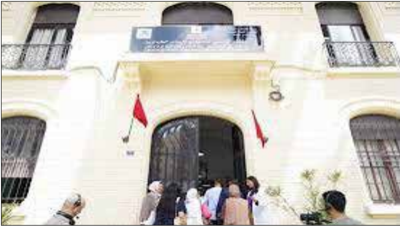
Les bâtiments portent les stigmates du temps: locaux vieillissants, infrastructures dégradées.
