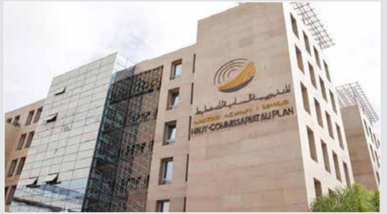
La réforme vise à moderniser la gouvernance des statistiques publiques.
