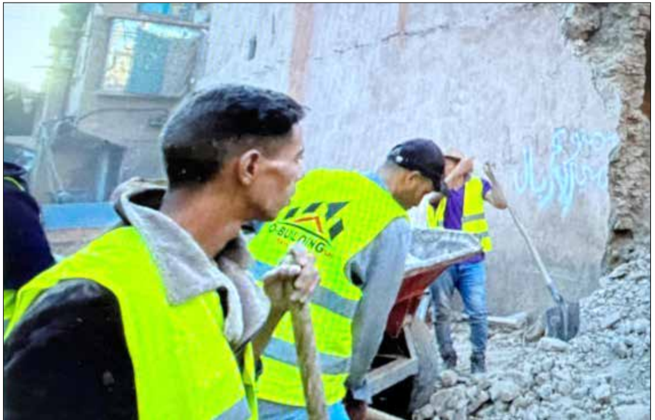
Le chantier de la reconstruction mal engagé...
