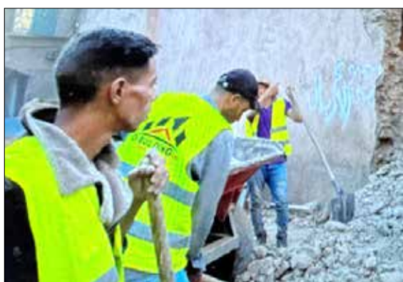
Le chantier de la reconstruction mal engagé...
