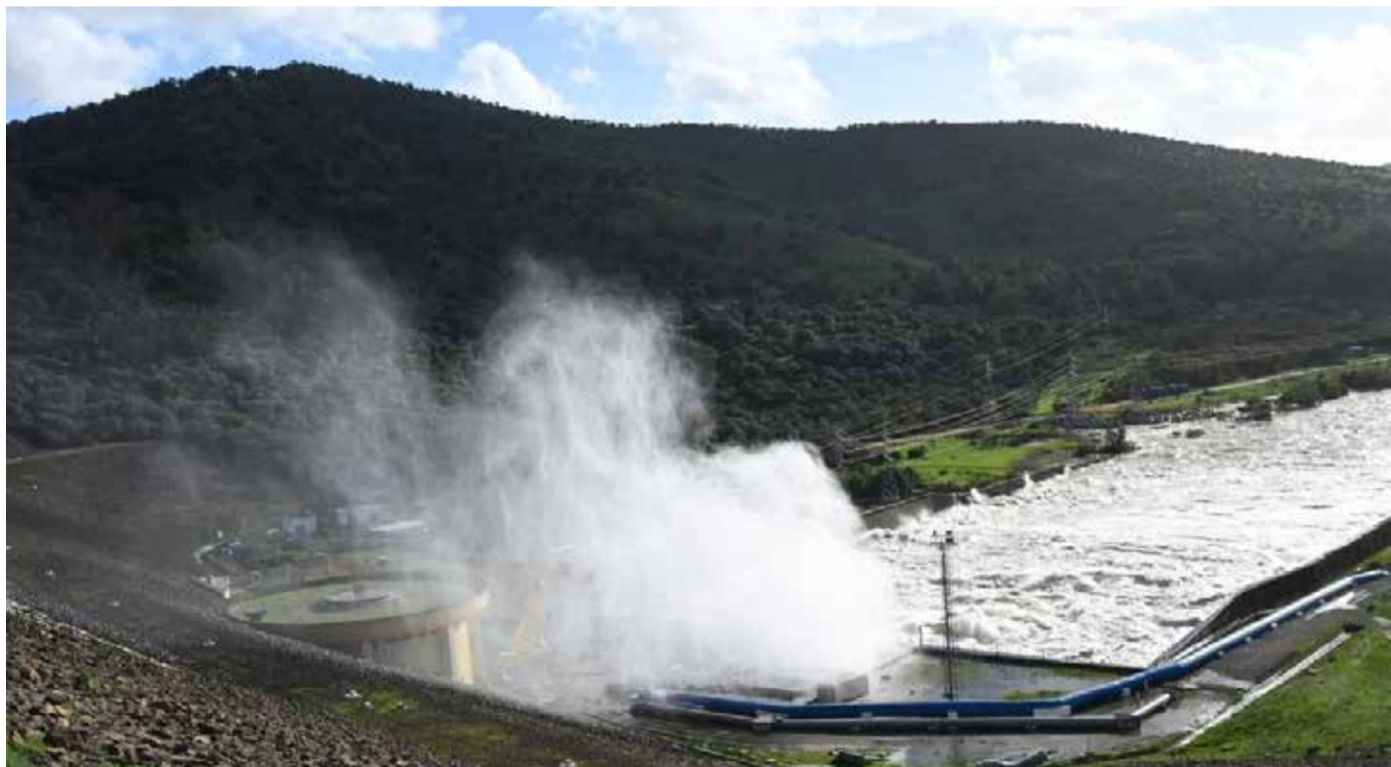
Les inondations récentes ne résultent pas d'une "surabondance permanente" de pluie, mais d'épisodes concentrés dans le temps.
