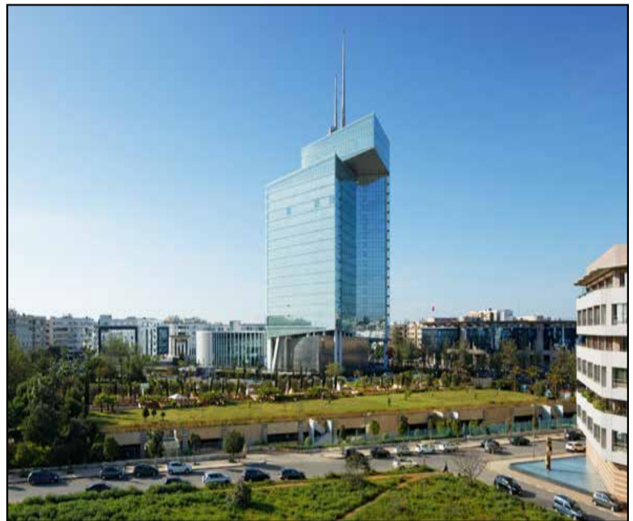
Maroc Telecom a fait appel de sa condamnation...
