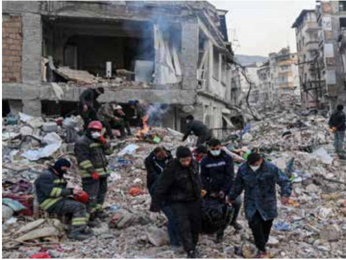
Une région complètement dévastée...
