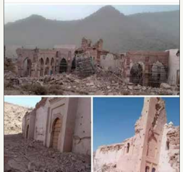
La mosquée de Tinmel après le séisme...
