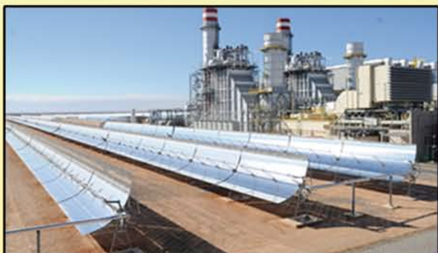
Centrale Thermo Solaire d'Ain Béni Mathar
