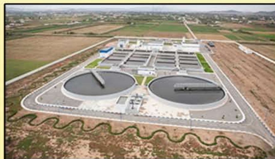
Station d'épuration des Eaux Usées - Grand Nador
