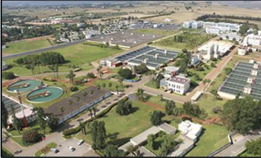
Station de Traitement des Eaux de Bouregreg - Rabat
