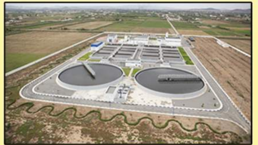
Station d'épuration des Eaux Usées - Grand Nador
