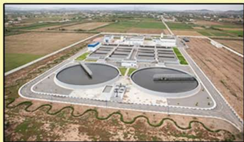
Station d'épuration des Eaux Usées - Grand Nador
