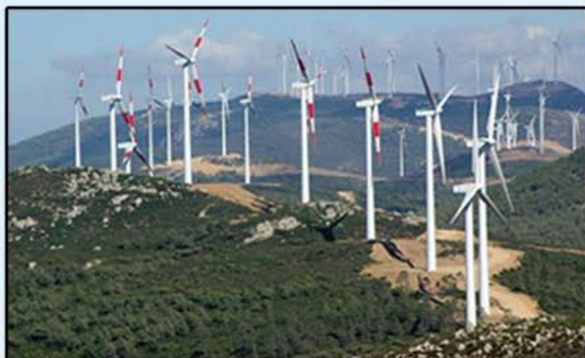
Parc Eolien de Tanger
