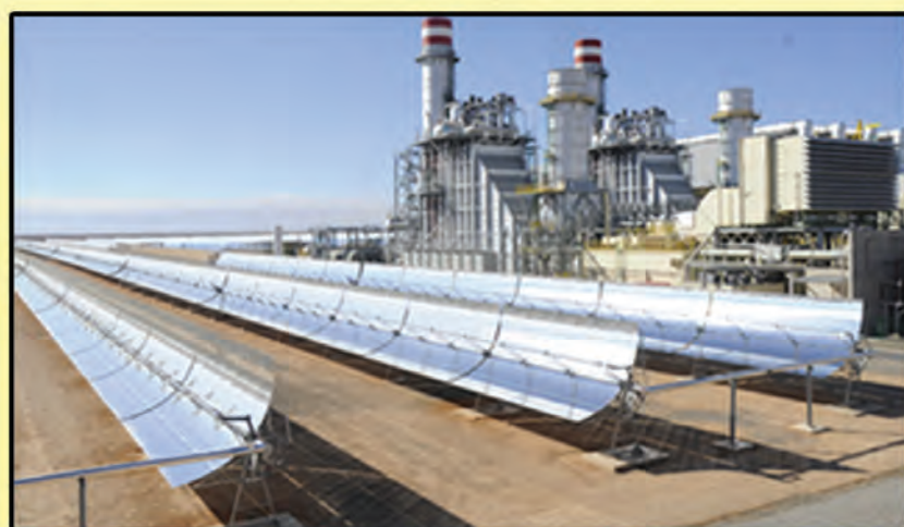
Centrale Thermo Solaire d'Ain Béni Mathar
