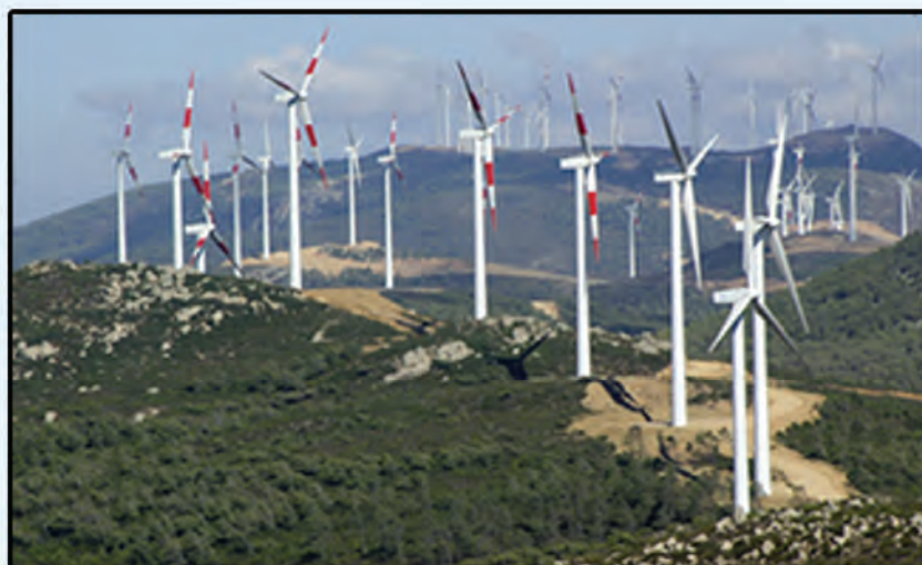
Parc Eolien de Tanger
