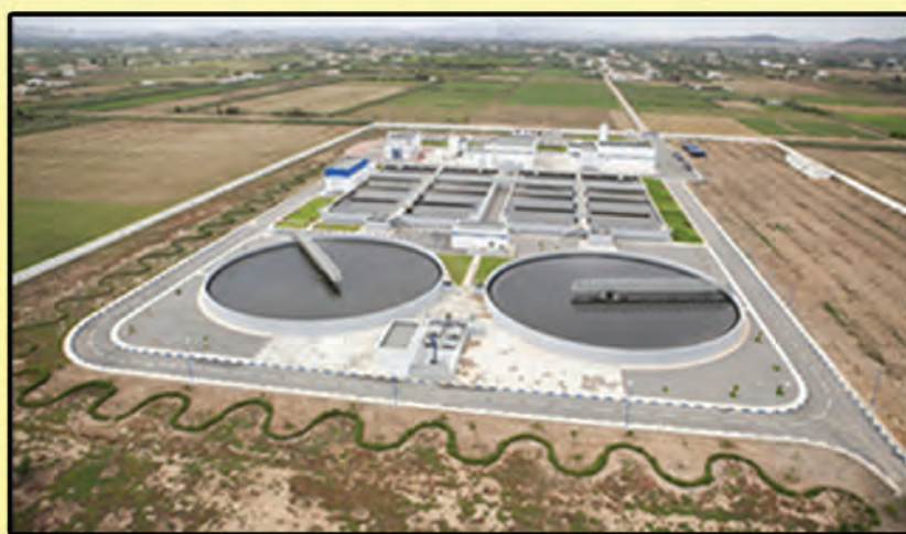
Station d'épuration des Eaux Usées - Grand Nador
