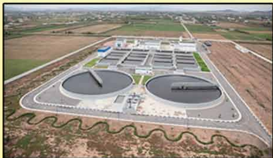
Station d'épuration des Eaux Usées - Grand Nador
