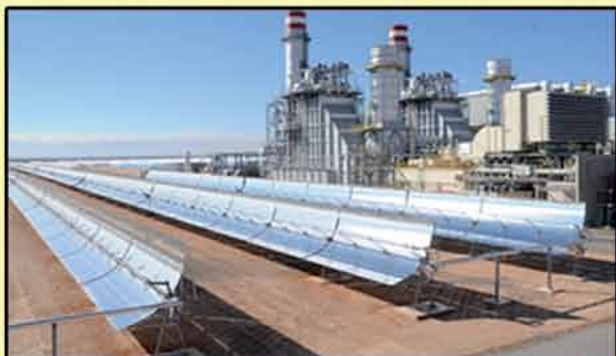
Centrale Thermo Solaire d'Ain Béni Mathar
