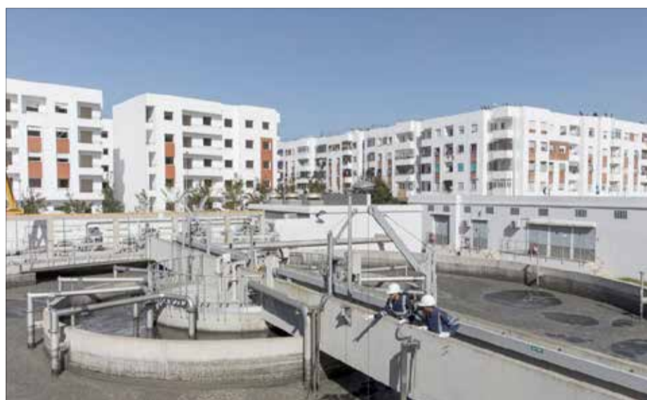
Les eaux usées traitées de la STEP sont utilisées pour l'arrosage du jardin et les boues déshydratées sont utilisées comme fertilisants.
