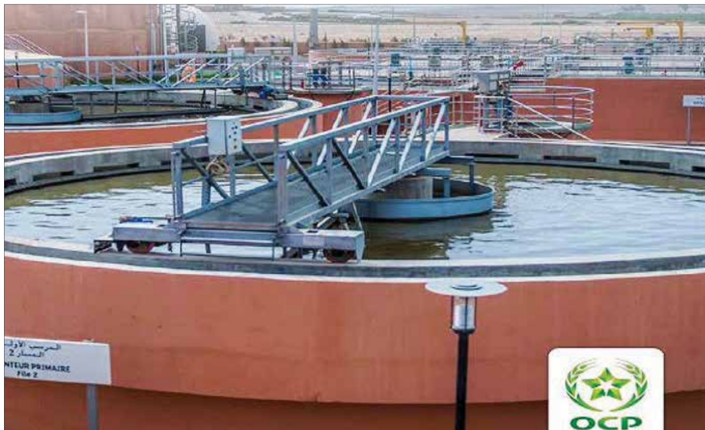
La station d'épuration de Khouribga du groupe OCP.
