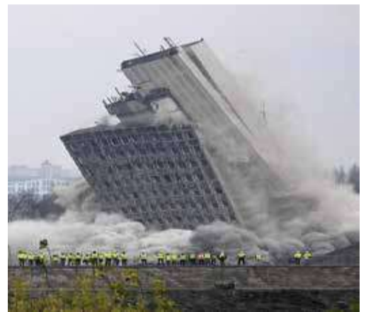
Le personnel de sécurité regarde un ancien immeuble de bureaux s'effondrer le 10 décembre à Budapest, près du Danube. A la place, le futur stade d'athlétisme de Budapest avec un parc public sportif et récréatif qui devrait ouvrir pour les championnats du monde d'athlétisme 2023. Photo Attila KISBENEDEK / AFP.
